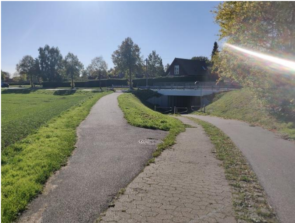
Figur 4 Foto, der viser tunnelføringen under Slagslundvej. Lokalplansområdet ses til venstre i billedet.
